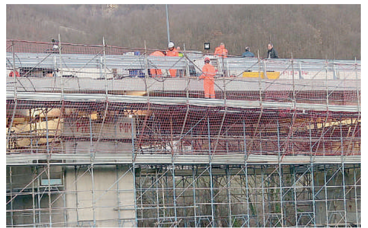
Operai al lavoro sul ponte di Farini FOTO MARINA
